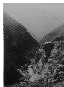
写真5 大正11年9月被災した1号堰堤の跡 19)
