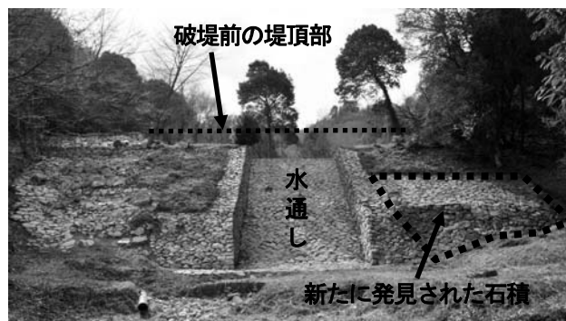
写真-1 七番砂留の下流側全景
