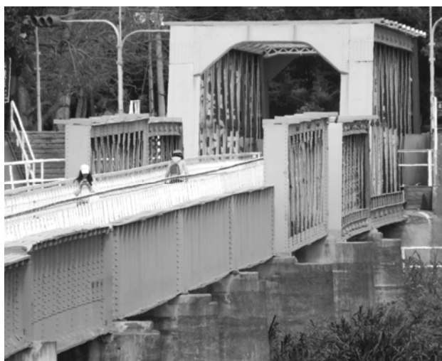
図-6 多様な構造からなる虎尾鉄橋
