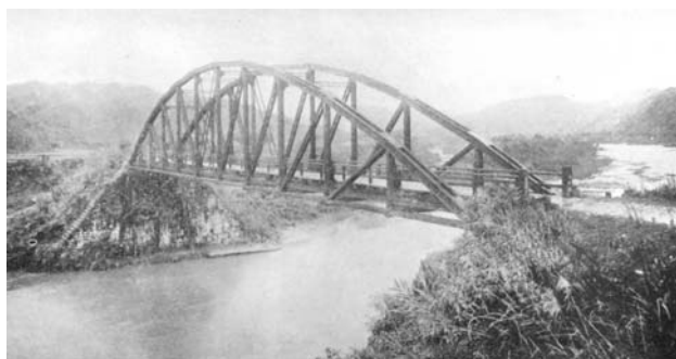
出典：台湾鉄道史（上巻） 図-8 基隆川橋梁（道路橋の状況）
