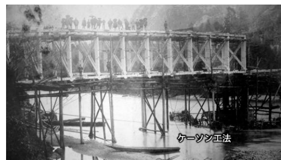
写真-2 架設中の笹津橋(立山カルデラ砂防博物館蔵)
