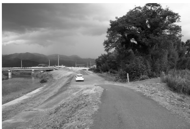
図-1 城原川の野越システム (越流堤・霞堤・水防林・水路の複合施設)
