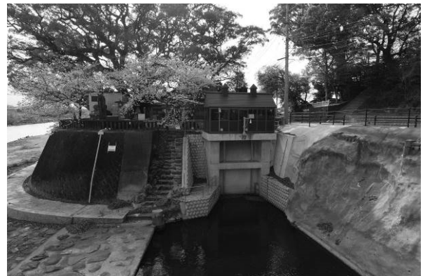
図-1 改修により旧来の水門が失われた山田堰
