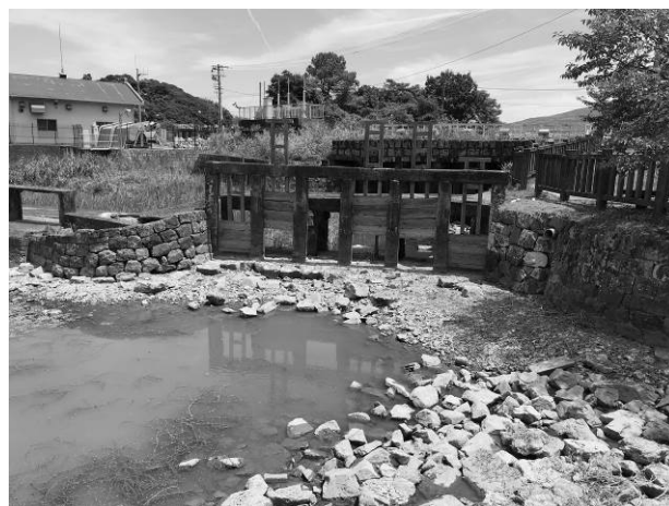
図-5 石塘の水門遺構(六枚井樋)
