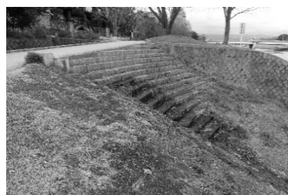
図-13 「階段護岸設置」工事の例（第36号堰堤協に平成元年施工．筆者撮影）
