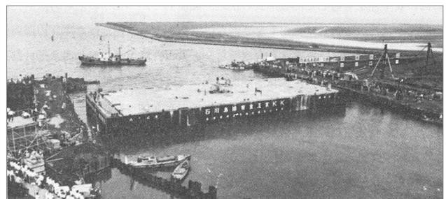
図-19 1号羽田線 羽田トンネル 沈埋函<sup>78)</sup>
