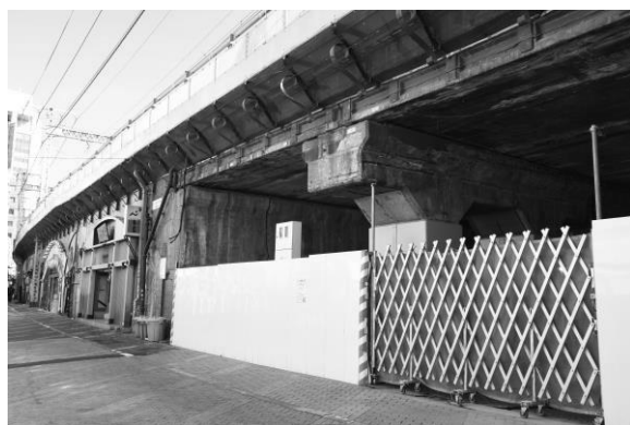
写真-3 第1有楽町橋高架橋のアーチ改築部分の現状
