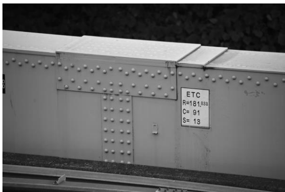
写真-5 御茶ノ水橋梁のリベット接合
