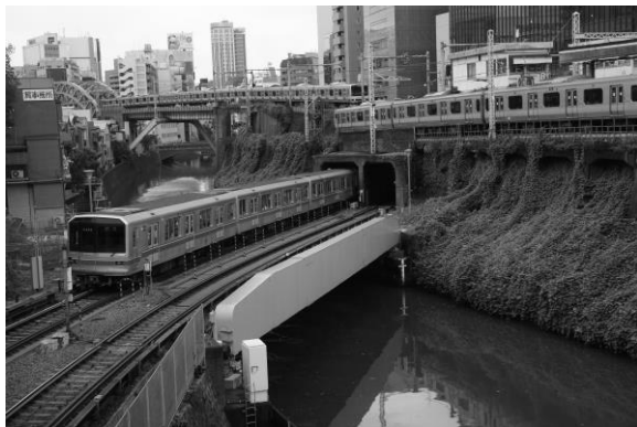
写真-4 御茶ノ水橋梁の現状
