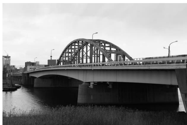
写真-8 新淀川橋梁（新淀川大橋）の現状
