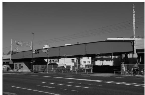
写真-6 馬込第 1 架道橋の現状
