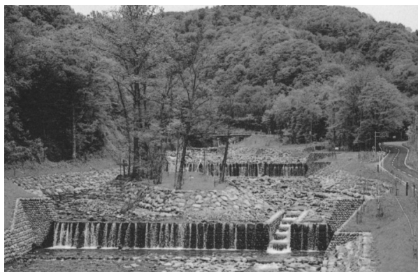
写真-3 環境配慮型砂防施設の設計と施工
