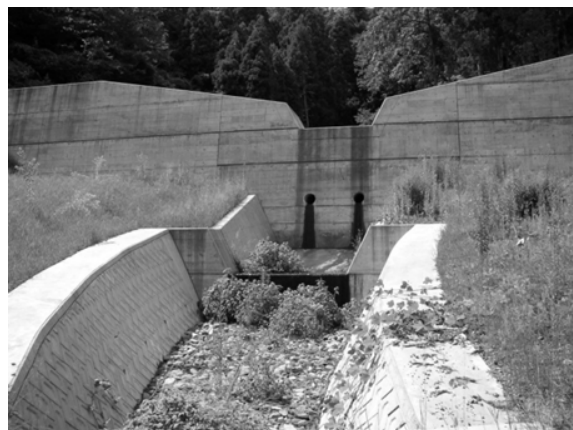
写真-1 標準的なコンクリート製砂防堰堤
