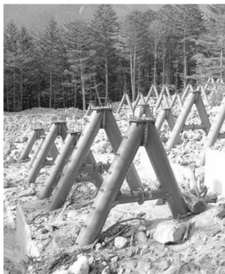
写真-2 日本で初めて設置された鋼製スリット A 型砂防堰堤 (砂防鋼構造物ガイドブック)
