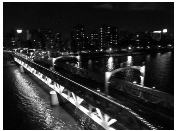
図-4 ライトアップされた東武線隅田川橋梁
