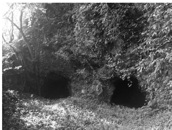
写真-5 隧道⑯出口側の全景(撮影:本田)
