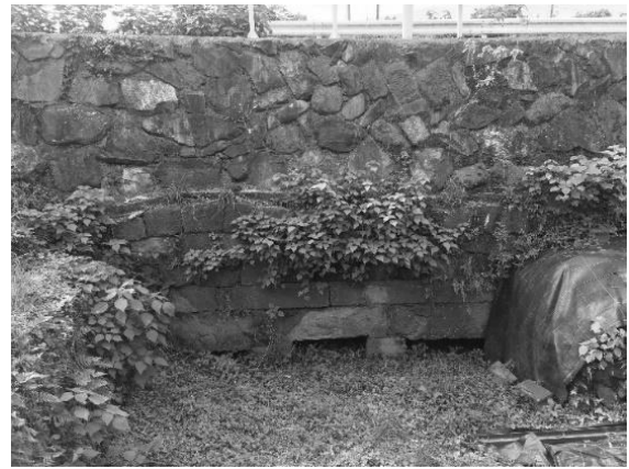
写真-3 平良川底水道（撮影：本田）
