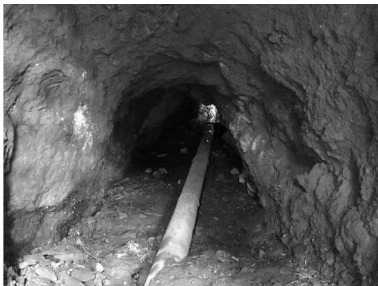
写真-2 隧道内に敷設された送水管（撮影：本田）
