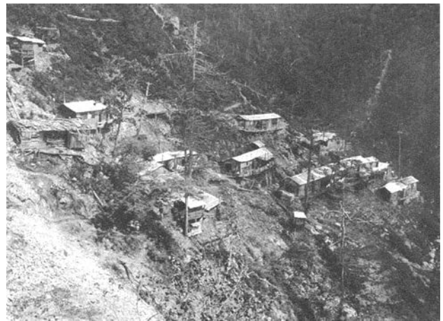
写真4 間組第一横坑における村上春蔵の飯場 20)
