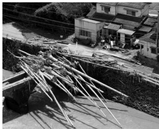
写真1 災害時の流木と宮ヶ原橋の状況
