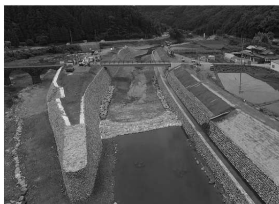
写真7 改良復旧の空撮(下流側から上流側へ)
