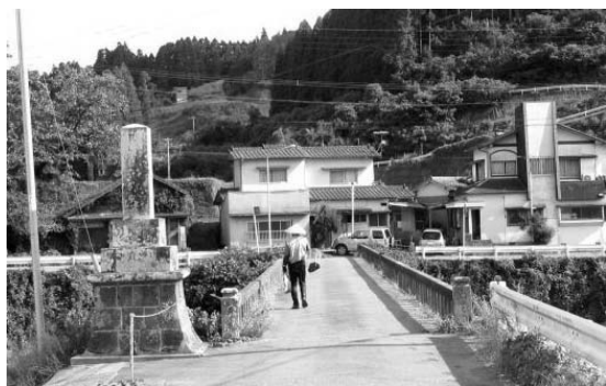
写真5 被災前の宮ヶ原橋の様子
