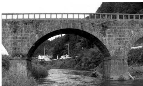
写真6 被災前の宮ヶ原橋の様子
