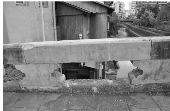
写真-3 崩落・断裂した手摺の修復後の状況 （撮影：本田、2017. 12. 10）
