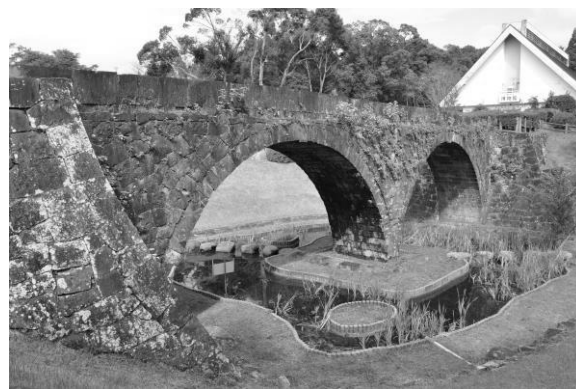
写真-21 大坪水路橋全景 (撮影: 本田、2016. 09. 21)
