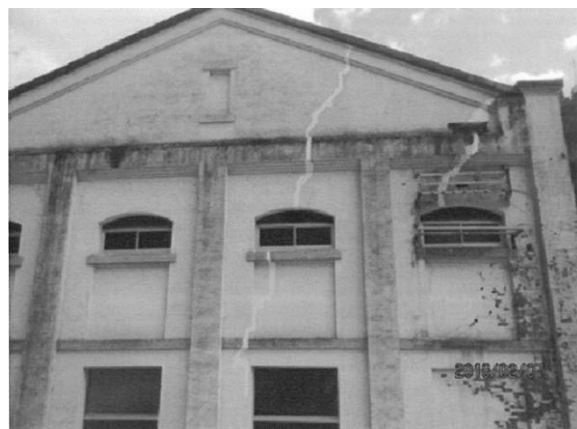
写真-20 西側側壁開口部近景 (JNC株提供)
