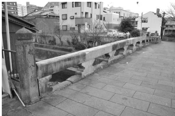
写真-2 下流側高欄全景（撮影：本田、2017. 12. 10）
