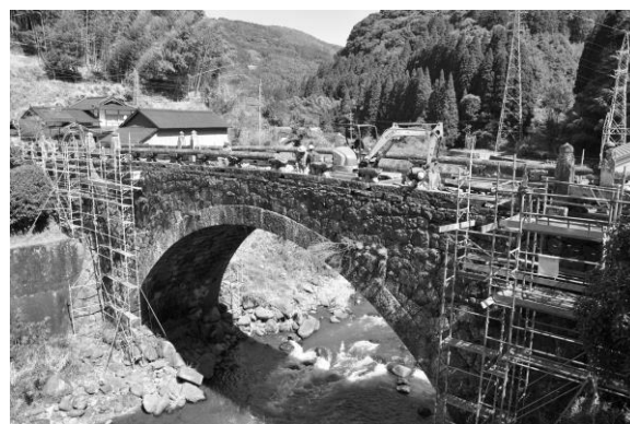
写真-9 作業全景（撮影：本田、2018. 03. 17）
