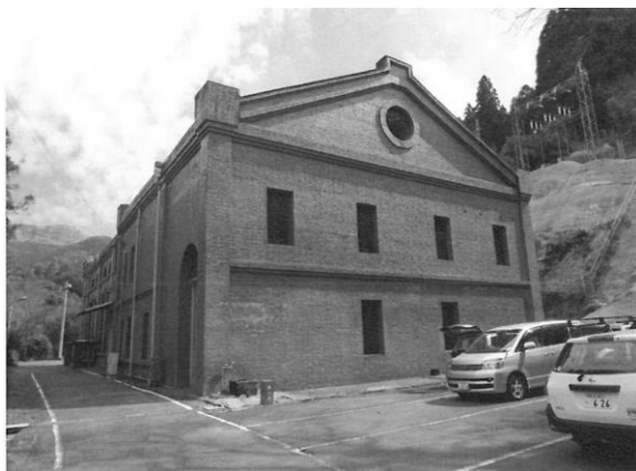
写真-13 被災前南側壁面 (JNC(株)提供)
