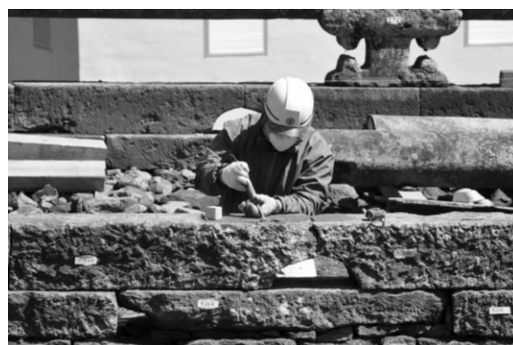
写真-10 ダボ新設作業状況 （撮影：本田、2018. 03. 17）
