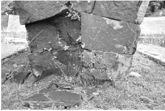
写真-22 橋脚下部の状況 (撮影:本田、2016. 09. 21)
