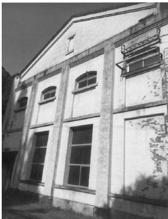
写真-17 西側側壁修復前全景 (JNC株提供)
