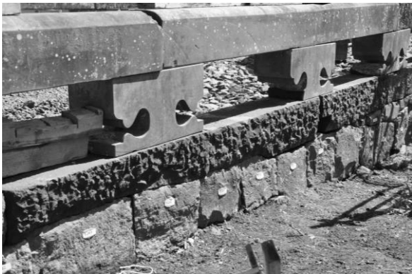
写真-12 新たに製作された石材 (下から二段目) (撮影:本田、2018.03.17)
