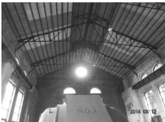
写真-14 被災前北側内部 (JNC(株)提供)
