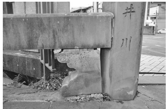
写真-4 下流右岸側親柱付近 （撮影：本田、2017. 12. 10）
