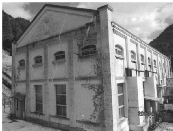
写真-19 西側側壁修復後全景 (JNC株提供)
