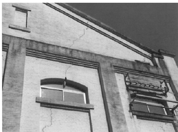
写真-18 西側側被開口部近景 (JNC株提供)
