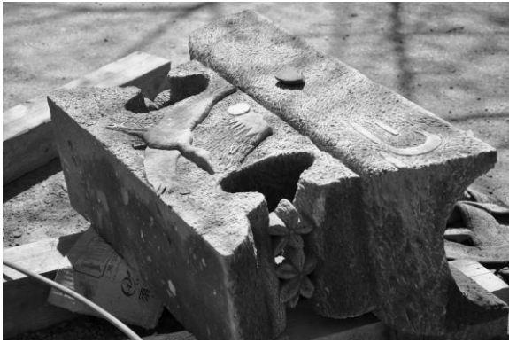
写真-11 製作中の束柱 (撮影:本田、2018.03.17)
