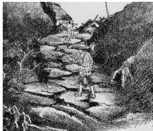
図-8 金沢駅端土地の大亀裂
