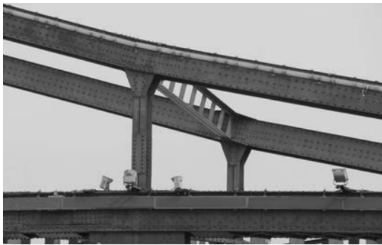
図-11 鴨緑江橋梁の吊弦材，上弦材，鉛直材（撮影：高橋）
