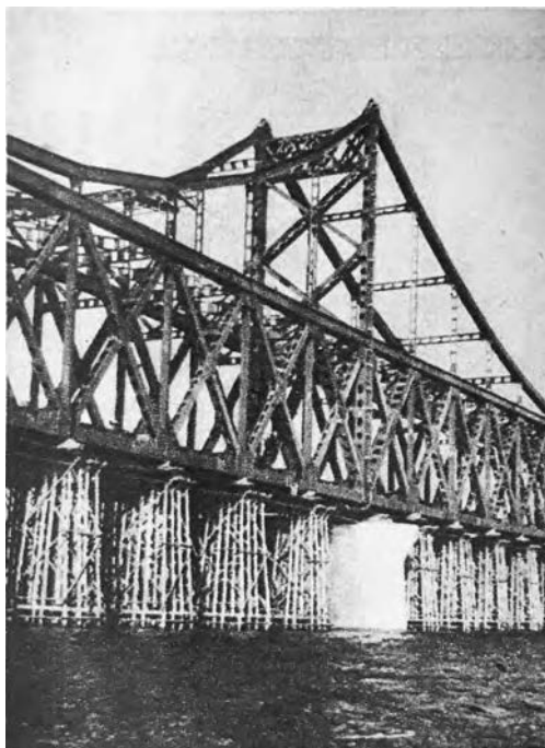
図-12 各格点位置に足場が建設された初応力調整の状況 19)
