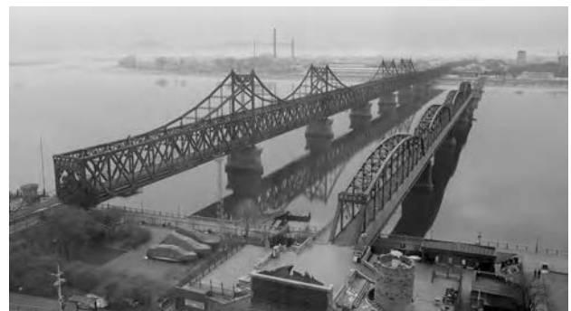
図-9 鴨緑江橋梁(撮影:高橋, 左が複斜材型トラス橋梁, 右は旧橋である単純トラス橋梁)
