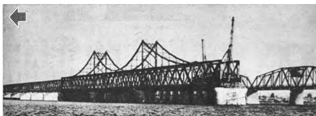
図-13 第一主径間の初応力調整を終えて最後の据付完了時 19)
