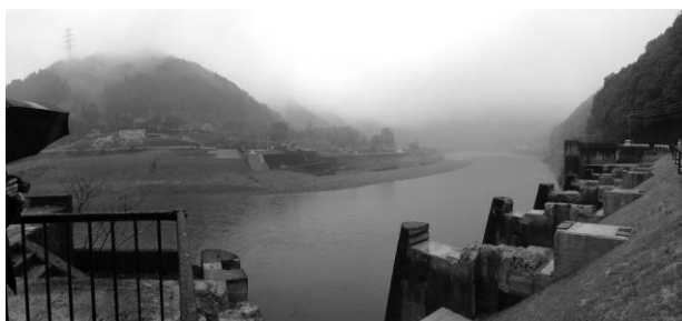
写真-2 撤去工事前の荒瀬ダム(上流右岸側より撮影)
