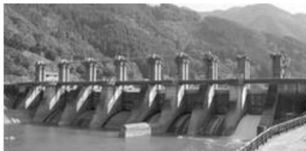
写真-1 撤去工事前の荒瀬ダム(下流左岸側より撮影)
