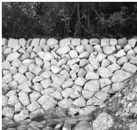
図-22 加工された石を用いた石積みの区間
