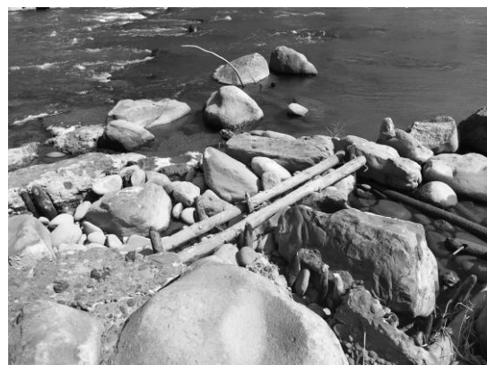
図-8 袋野堰 井桁跡
