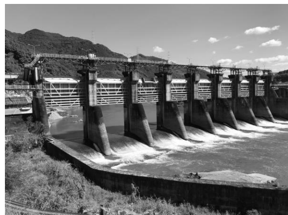
図-2 操業開始以来初めて全開となった夜明ダム
