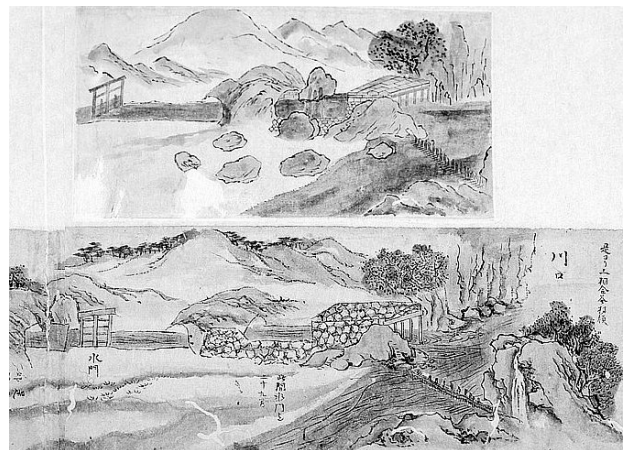
図-14 上水図における古川口の地震前後の状況（上段が地震後，下段が地震前の状況）
