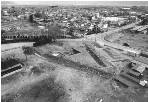
写真 4・六科櫛形堤防
