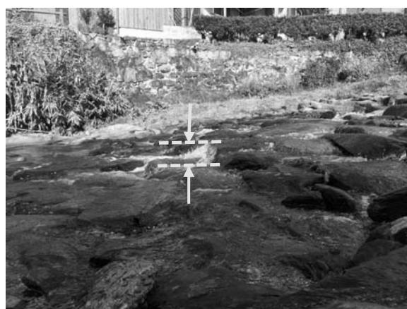
図 2-2-5 石の表面が水平な積み方
