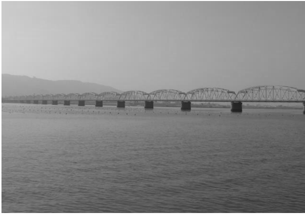
写真-1 吉野川橋
