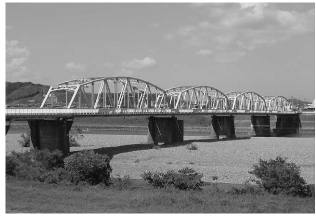
写真-2 那賀川橋
