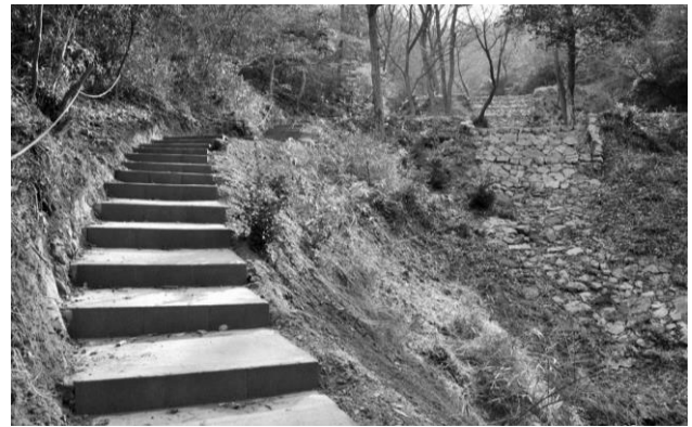
写真-9 十三番砂留までの急斜面に設置された階段
