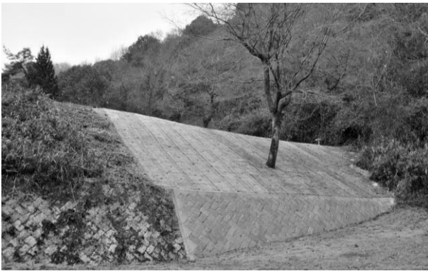
写真-8 練石積を施工して修繕された三番砂留の土堰堤
