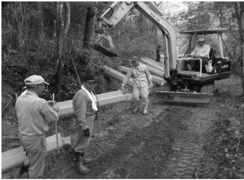
写真-1 「守る会」で実施したU字溝の設置
