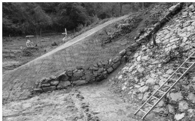
写真-7 崩壊していた石積と土堤が修復された五番砂留
