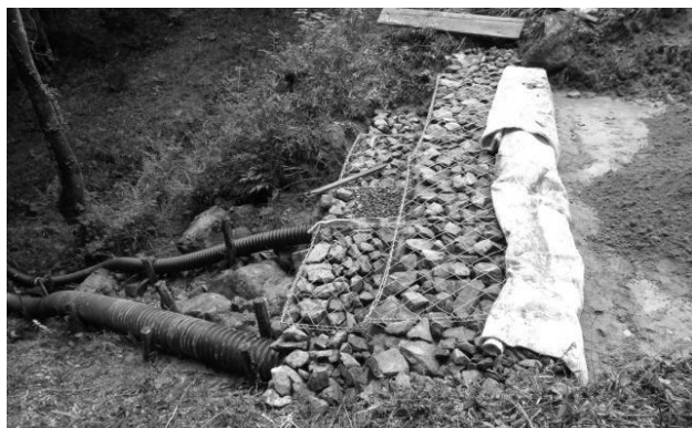
写真-6 水抜き管とふとん籠を施工中の二番砂留
