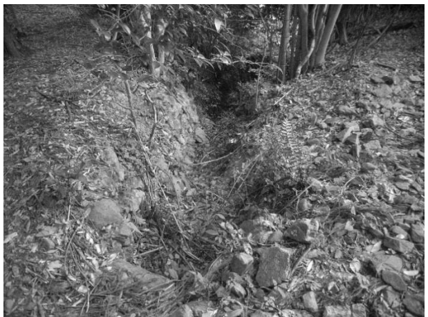
写真-2 上部の出水部
