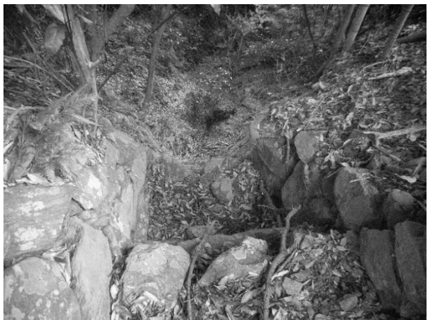
写真-3 出水部の段構造
