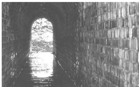
図-6 馬蹄形煉瓦下水道（第二期工事）
