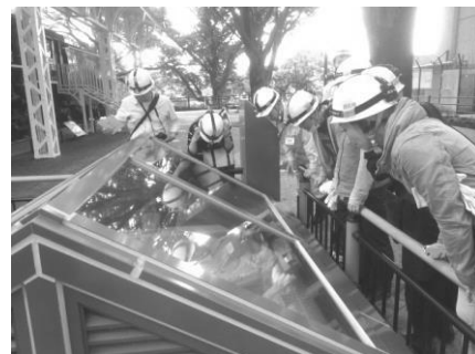
図-9 煉瓦下水道が見える天窓
