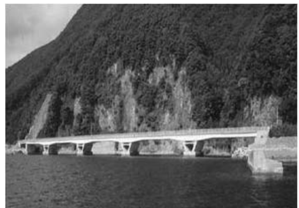
写真-3 黒姫大橋
