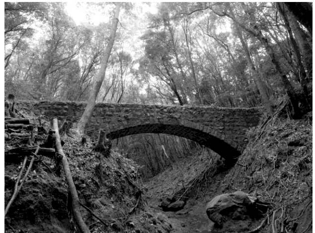
写真-5 巢の浦線の山間部にある石橋(撮影寺村)
