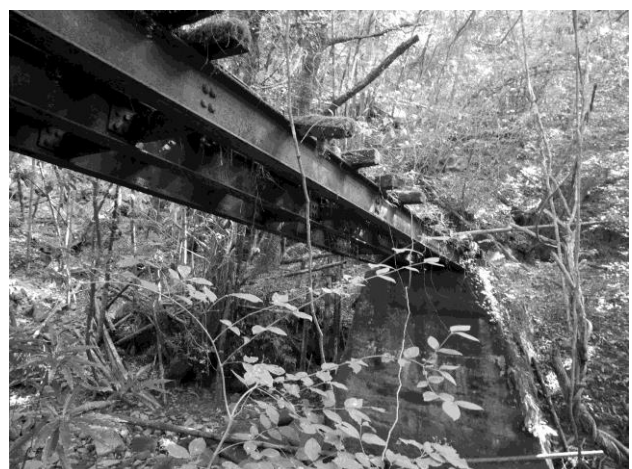
写真-3 ガーター橋遺構 (撮影：寺村)
