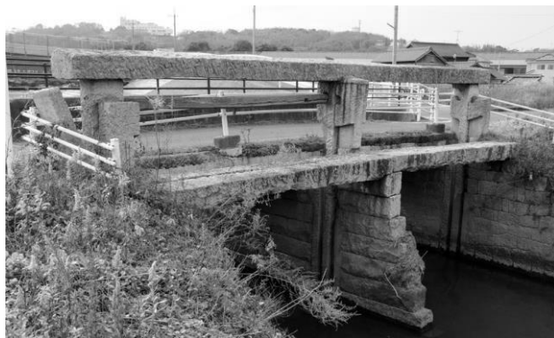
写真-1 撤去前の倉水門（2014.1.28. 著者撮影）
