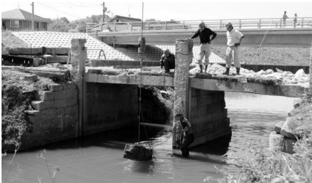
写真-2 笠石、梁、橋脚部の石材はクレーンで解体された (2016.5.18. 著者撮影)
