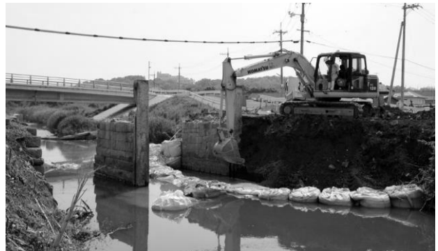
写真-3 両岸の石積みは重機で破壊された (2016.5.23. 著者撮影)
