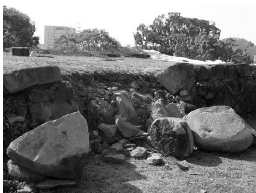
写真-1 本丸御殿側小広間台石垣
