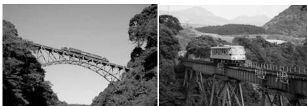
写真-1 第一白川橋梁
