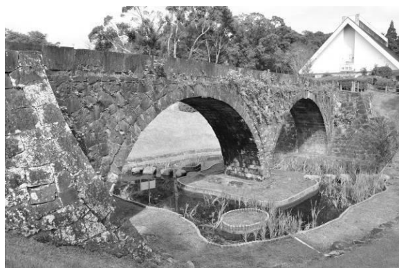
写真-9 大坪水路橋全景（撮影：本田、2016. 09. 21）
