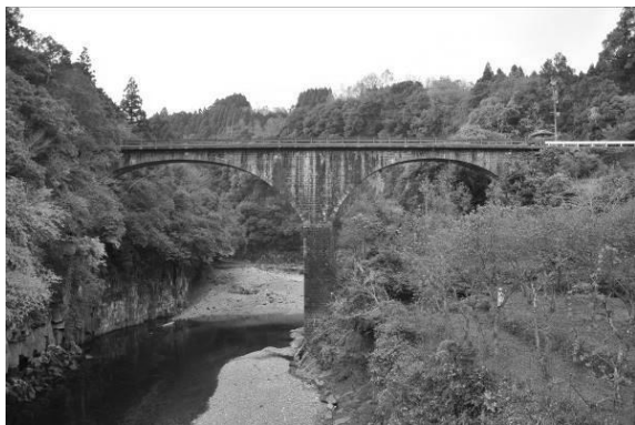
写真-28 轟橋遠景（下流側から） （撮影：本田、2016. 11. 29）
