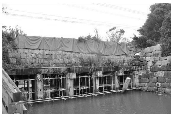
写真-23 穀樋遠景 (撮影:本田、2016. 04. 20)
