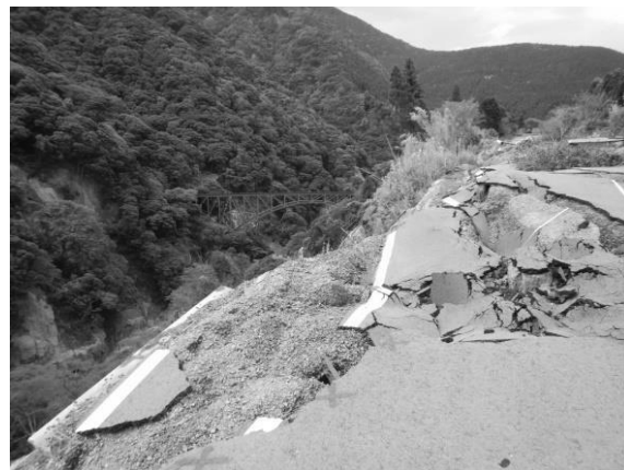
写真-3 第一白川橋梁遠景（上流右岸側から） （撮影：阿部、2016. 09. 04）
