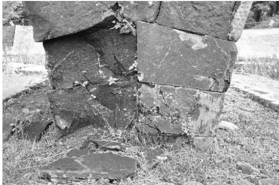
写真-10 橋脚下部の状況（撮影：本田、2016. 09. 21）
