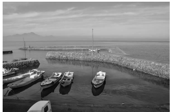
写真-15 赤瀬港全景（崩落部は右手前） （撮影：本田、2016. 12. 18）
