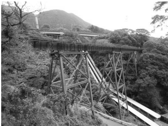
写真-5 立野橋梁遠景（立野川南側から） （撮影：阿部、2016. 09. 04）
