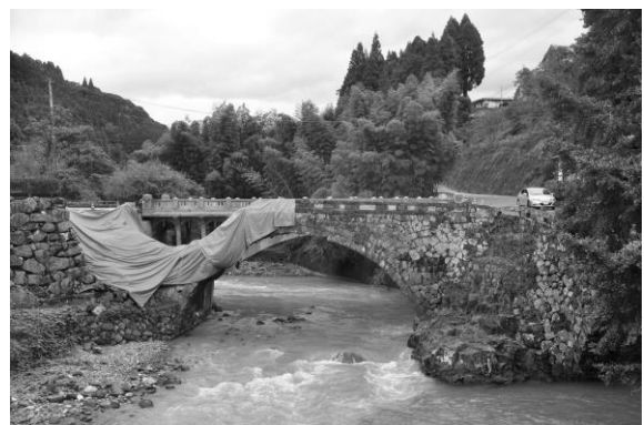
写真-20 二俣福良渡遠景(下流側から) (撮影:本田、2016.09.20)
