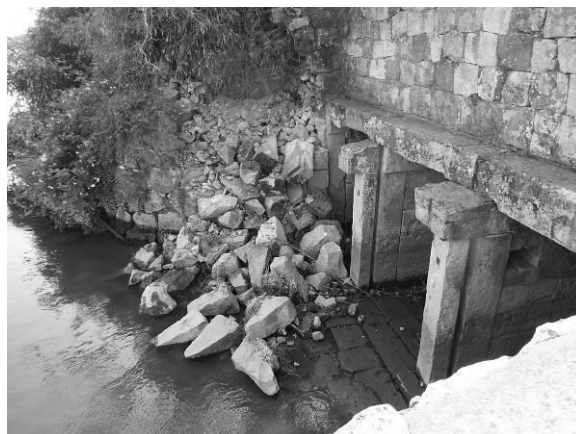
写真-26 江中樋鞘石垣崩落部 (撮影:八代市文化振興課、2016. 04)
