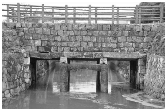
写真-24 二番樋遠景 (撮影:本田、2016. 09. 20)
