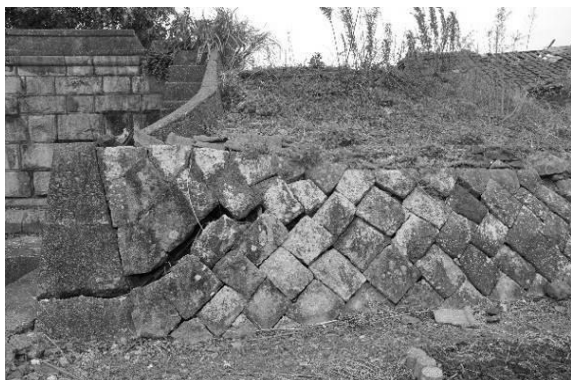
写真-2 北側の堤体（撮影：本田、2016. 09. 20）
