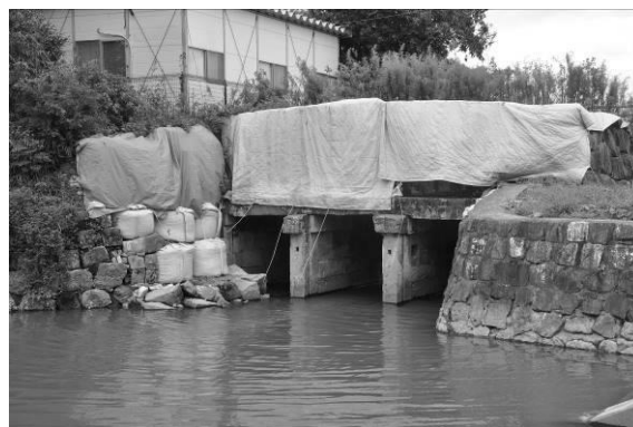
写真-27 江中樋遠景 (撮影:本田、2016. 09. 20)
