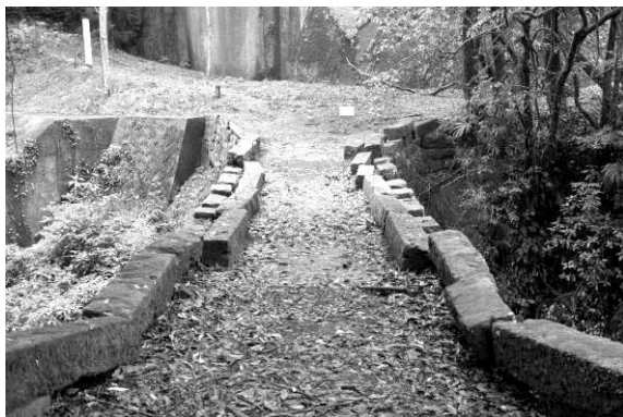
写真-18 橋面の様子 (撮影:本田、2016.09.20)
