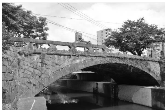
写真-7 明八橋遠景（下流左岸側から） （撮影：本田、2016. 05. 25）
