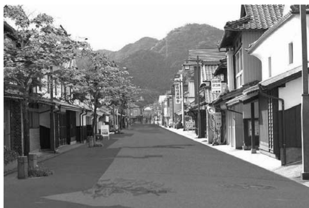
図7 アスファルト舗装
