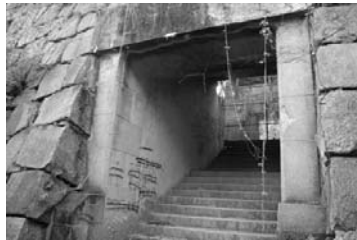
図5 現在の石垣隧道
