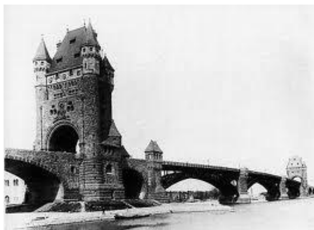
写真-3 エルンスト・ルードヴィッヒ橋
