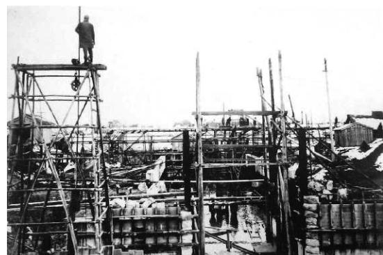
写真-1 萩の浦閘門施工写真(矢板打込み及び閘門室混凝土打ち作業)
