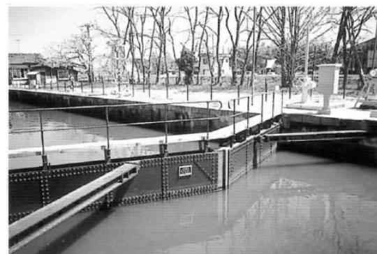
写真-3 復元された上流側門扉（リベット接合と水密部の檜）
