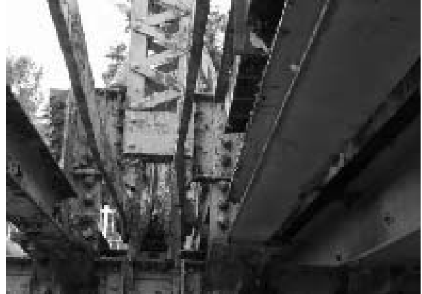
図6 大きく曲げ変形を受けた下弦材
