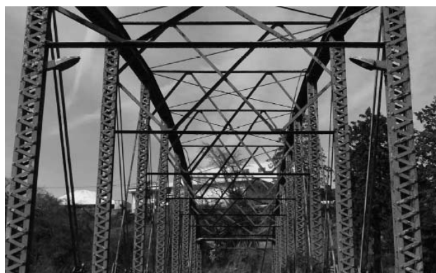
図11 垂直材、上横構、支材
