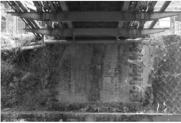
図 12 ブラケットと一体となった横桁
