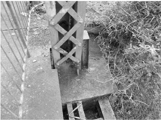
図 15 可動側(右岸)支点部
