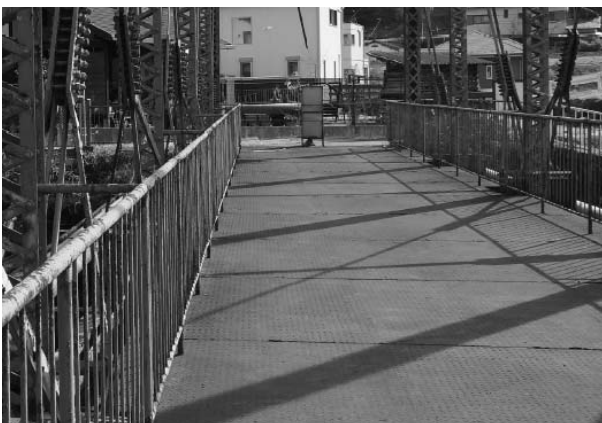
図 14 現況の床版は縞鋼板をデッキプレートとする鋼床版 フラットバーのリップで補剛された縞鋼板をデッキプレートとした鋼床版。
