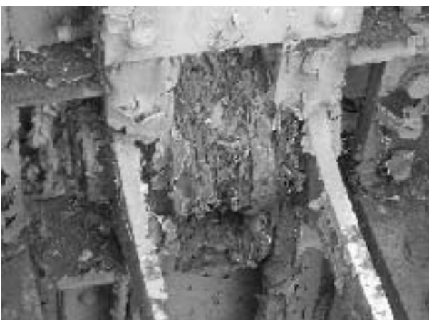
図5 下弦材格点部(拡大)
