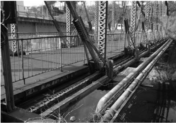
図3 補強された斜材, 下弦材
