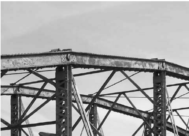
図8 比較的損傷、腐食、劣化の少ない上弦材
