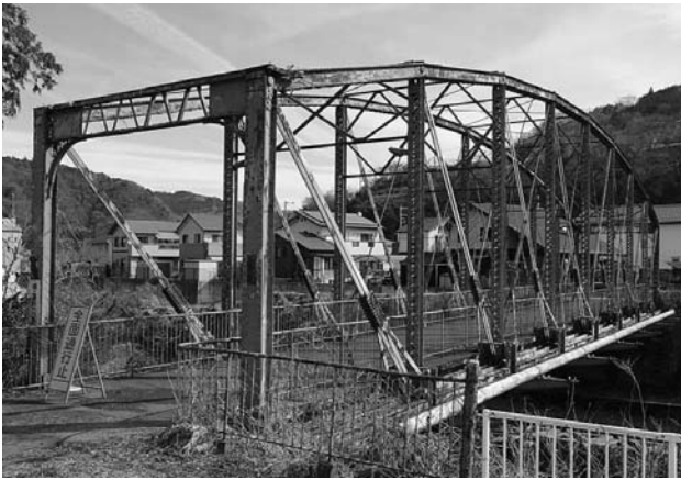
図1 森村橋全景（鮎沢川左岸上流側より、撮影 2015 年 2 月）
