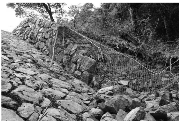
写真4 金属ネットによる崩落防止工
