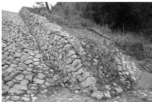
写真7 法面修復状況と登坂路の除去
