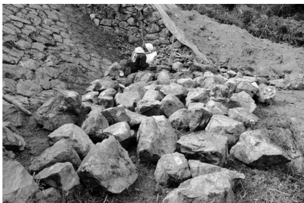
写真5 水叩きに並べられた石材の同定
