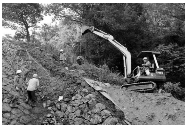
写真6 ユンボによる石材の据え付け
