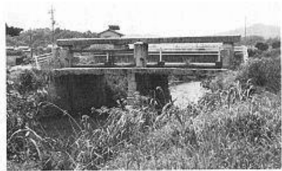
写真-1 「蔵水門」(倉敷市帯高地内) 4)
