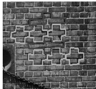
写真-7 左：石井閘門のイギリス十字積 右：毛馬閘門（淀川）のイギリス十字積 イギリス十字積はどの部分でも十字（クロス）となるデザイン。 通常のイギリス積は、十字（クロス）となる部分とならない部分が混在している
