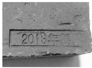
写真-5 新規の材料への刻印
