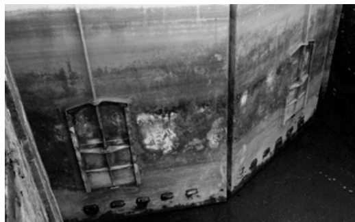
写真-6 今回の水抜き時に確認された小窓（H25.1撮影）
