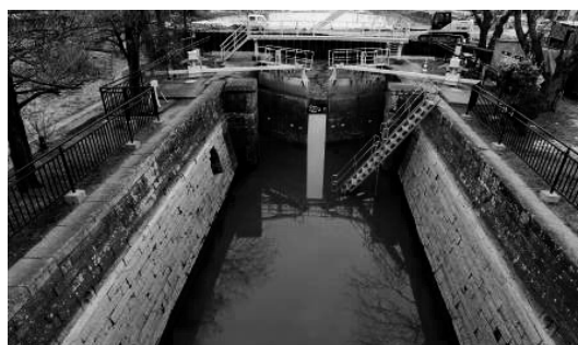
写真-3 水抜き調査状況（H25.1撮影）
