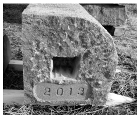
写真-5 新規の材料への刻印
