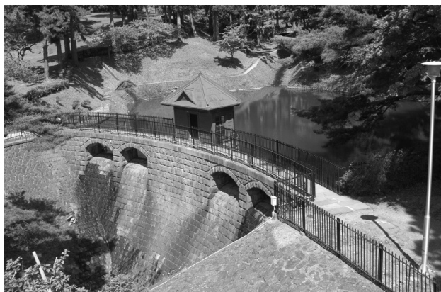
写真-1 旧大湊水源地水道施設 沈澄池堰堤
