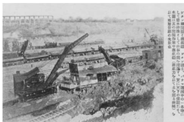
図-7 ガタン湖開削工事
