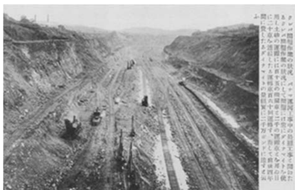
図-3 クレブラ開削作業
