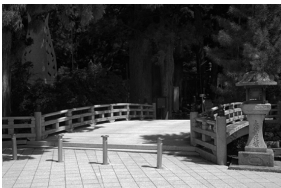
写真-17 高野山一の橋（和歌山）
