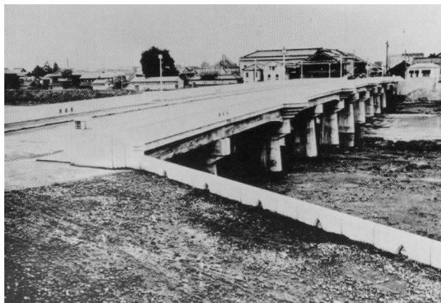
写真-1 完成した鉄筋コンクリート九十九橋 現在の橋梁は昭和61年5月にかかけえられもの
