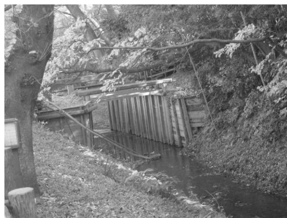
写真-1.2 見沼通船堀西縁第一の閘
