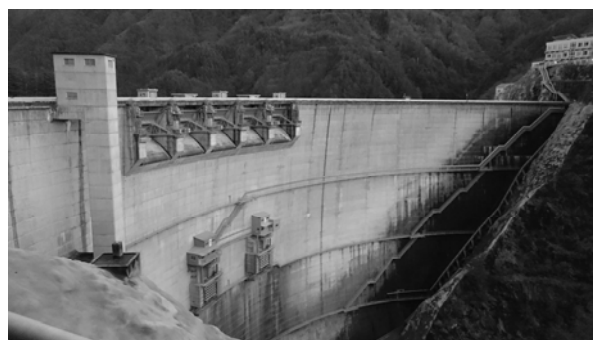
写真-1 小渋ダム堤体とエレベーター塔
