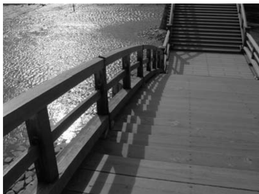
写真-7 錦帯橋の影
