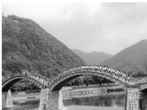
写真-2 地元の高校生による載荷試験
