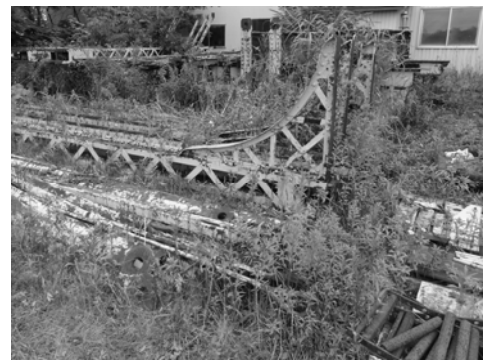
鉄橋部材の保管状況
