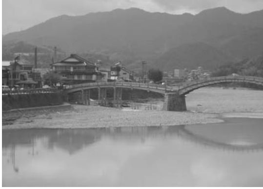
写真－4 2005年の台風後の錦帯橋
