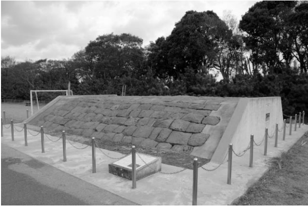
写真-2 復元された水軒堤防
