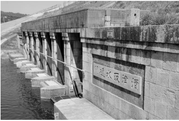
写真-8 現在の取水樋門
