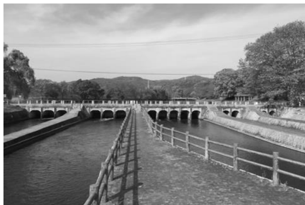
写真-6 現在の南配水樋門
