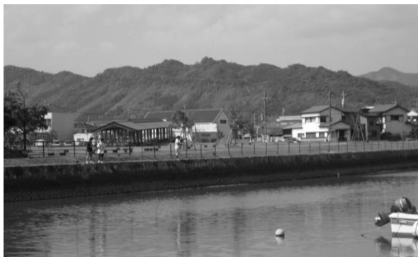
写真-1 再整備された現在の堀川運河
